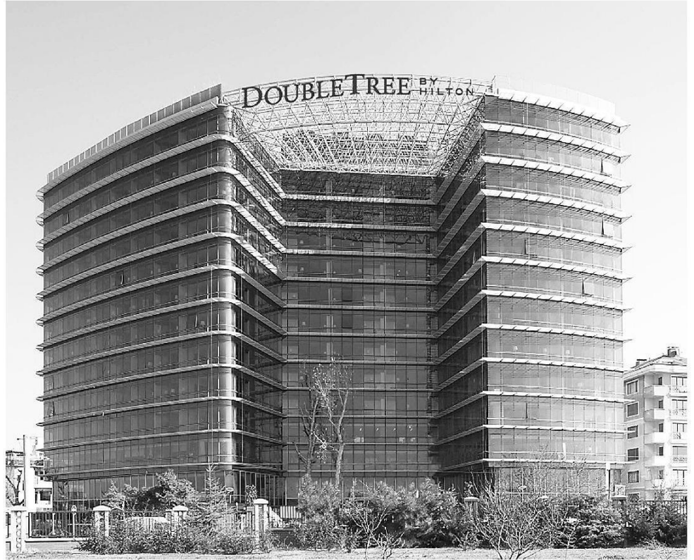
Tasyapı'nın 80 milyon lira yatırımla mal sahibi olduğu Doubletree by Hilton İstanbul-Moda hizmete girdi. Otelde 139'u deluxe 247 oda bulunuyor.
